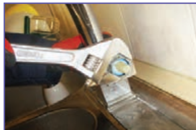
ث- باز کردن پیچ روی مغزی (گلند)
