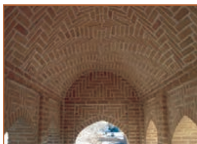
ب - استفاده از آجر برای سقف قوسی
